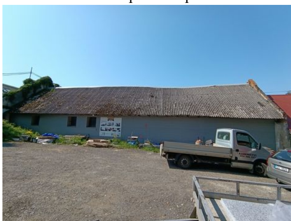
Budova bez č.p./č.e na parc.č. 578
