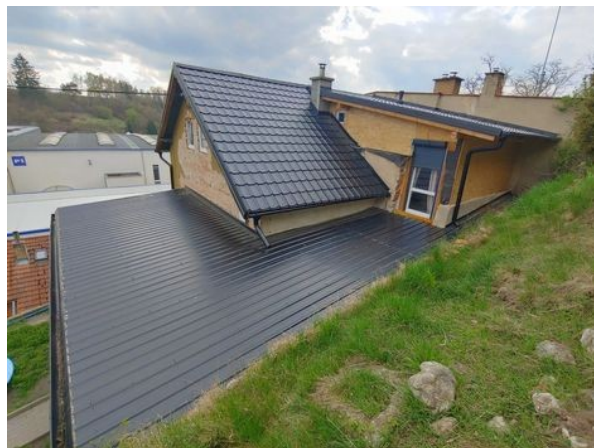
pohled na RD
