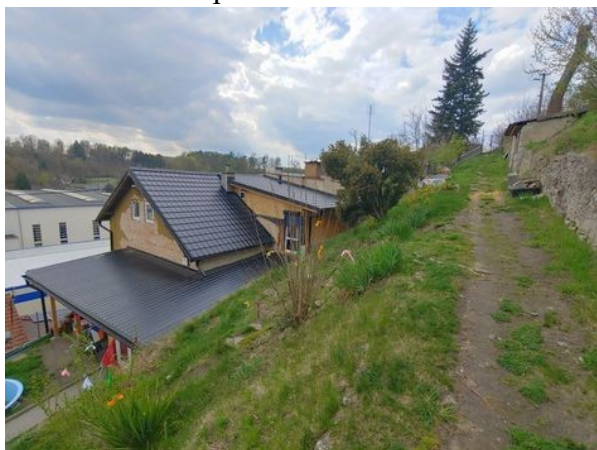
pohled na RD
