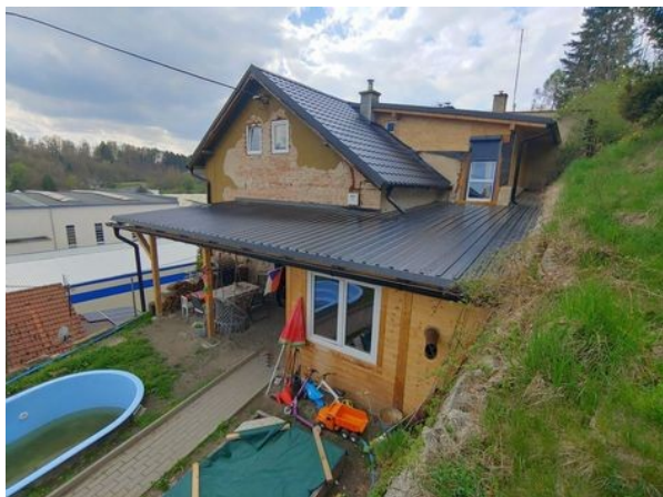
pohled na RD
