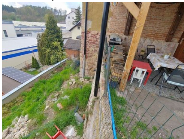
pohled na RD
