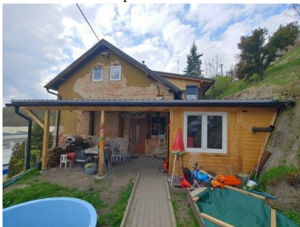
pohled na RD
