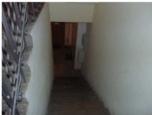
schodiště do 1.PP
