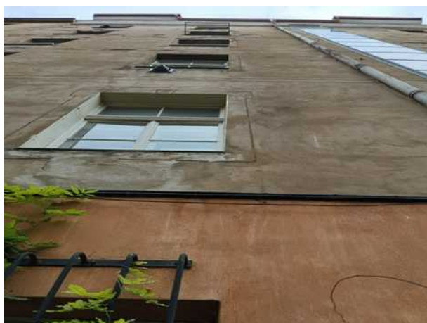
vstup z ulice
