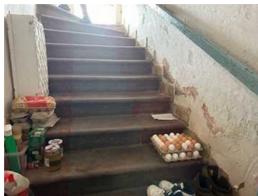
schodiště do podkroví
