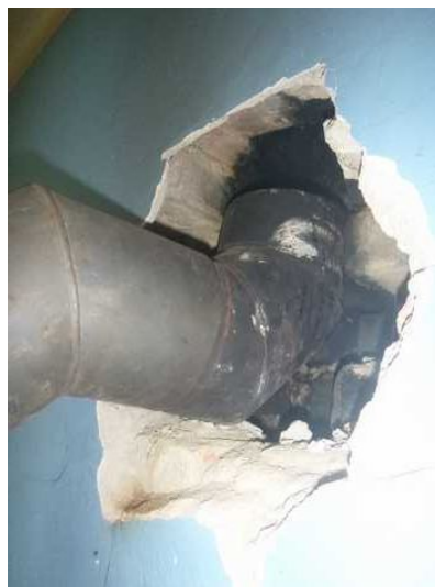
vadné zapojení kouřovodu
