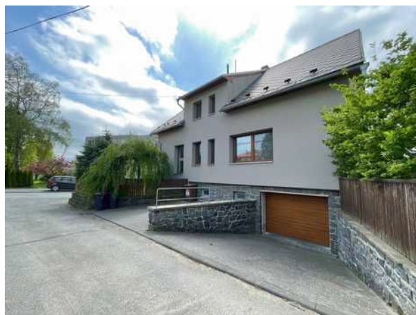
severovýchodní fasáda s vjezdem
