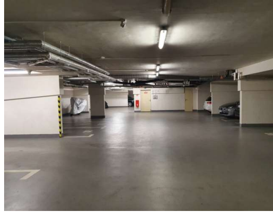
Prostory garáží v 1.PP
