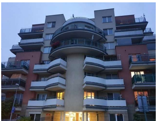
Pohled na bytový dům č.p. 713 z ul. Tupolevova
