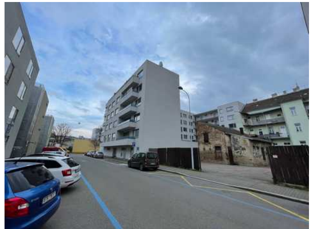
pohled z ul. Hybešova
