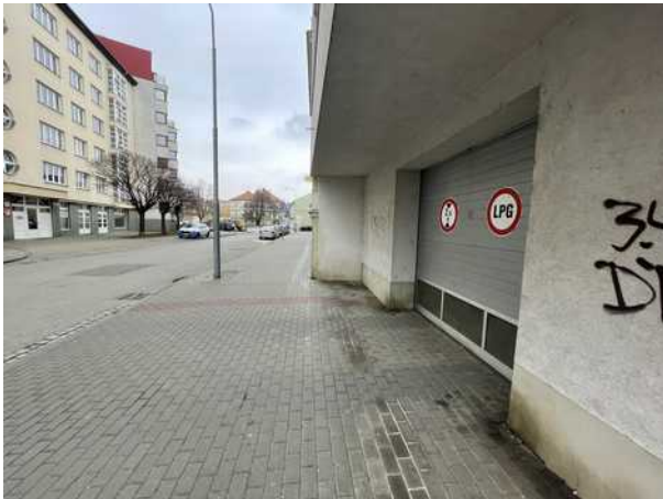
vjezd do podzemních garáží
