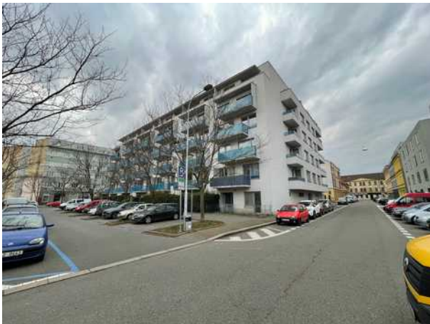
pohled z ul. Hybešova
