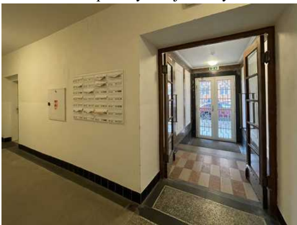
vstupní chodba se schránkami
