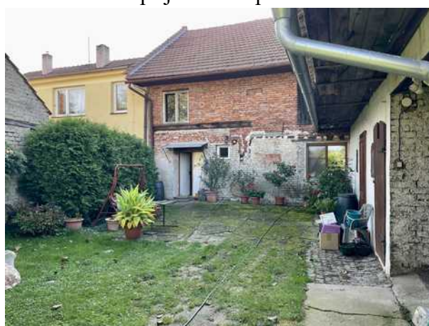
severozápadní fasáda s vedlejší stavbou
