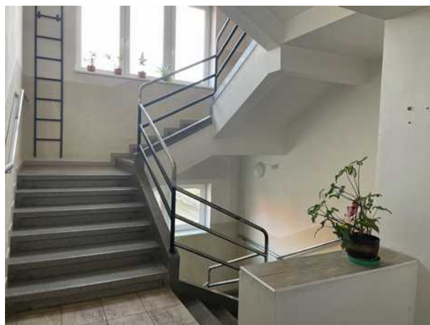
schodiště ve 2.NP
