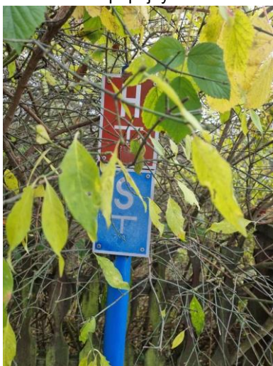
Přípojný bod vody
