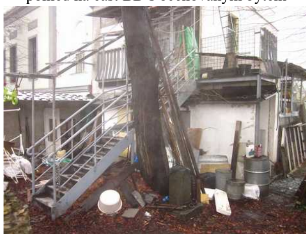
venkovní schodiště do bytu č. 22/4
