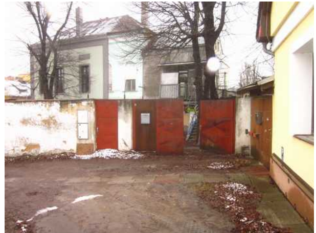
příjezd k pozemkům
