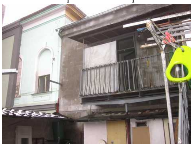
venkovní schodiště do bytu č. 22/4
