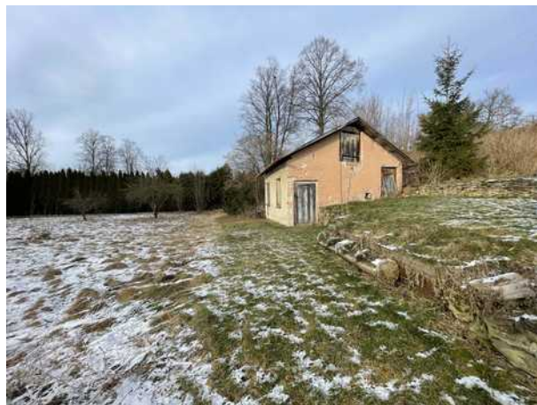
vedlejší hospodářská stavba
