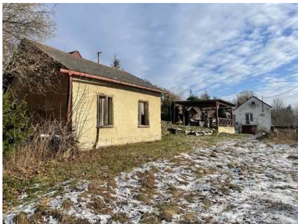
vedlejší hospodářská stavba
