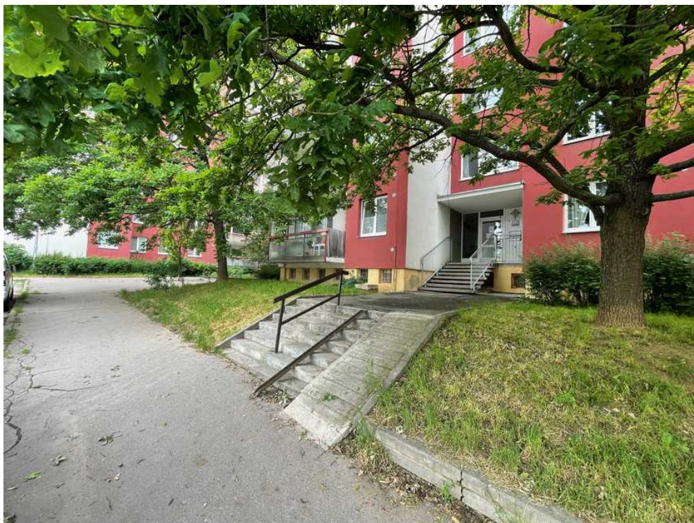
přístup k domu č.p. 4134
