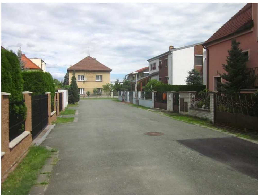
příjezd k pozemkům
