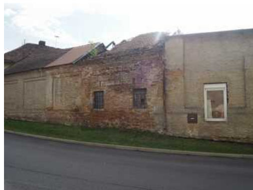
stavba bez čp/če - zem.stav.
