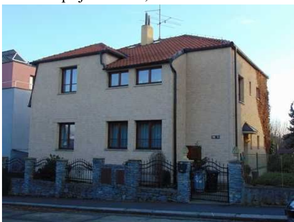
RD č.p. 756, pohled z ulice
