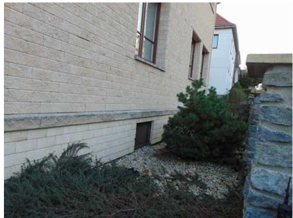
keramický obklad fasády
