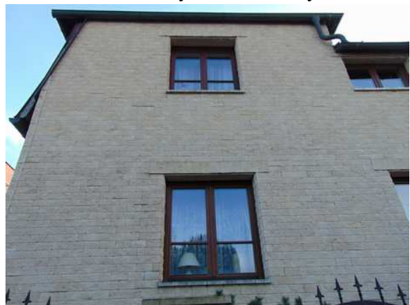
keramický obklad fasády
