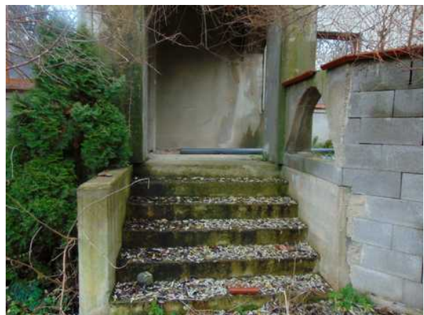
vstup do RD
