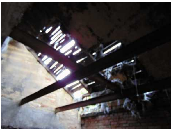
truhlářská dílna - střešní konstrukce
