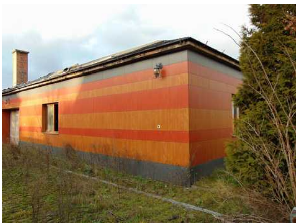
obložení fasády truhlářské dílny
