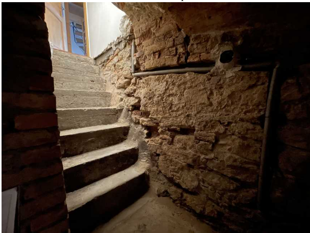
RD 1.PP schodiště do sklepa
