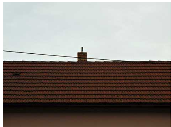
střešní konstrukce a krytina RD
