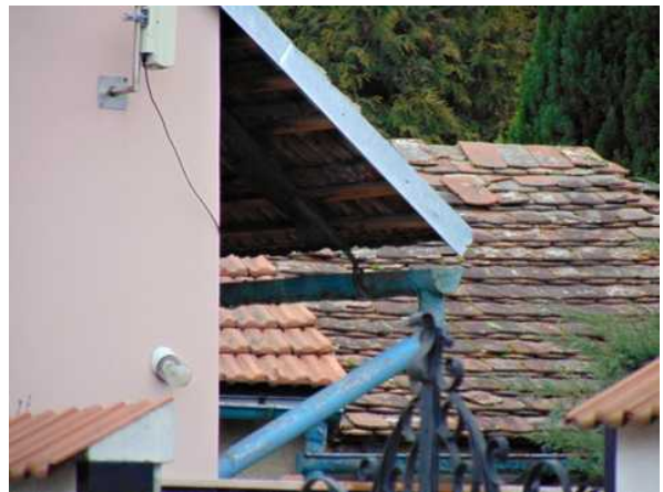
část přístavby k RD viditelná z ulice
