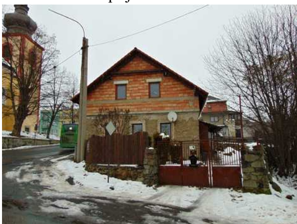
RD - čelní pohled
