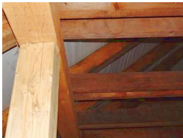
nová střešní konstrukce
