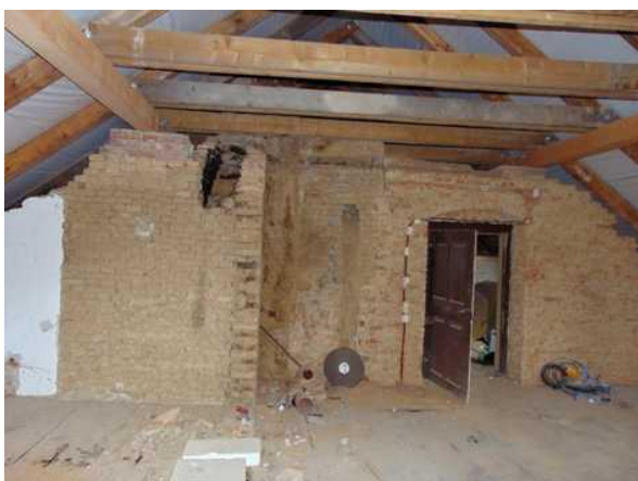
příprava na vestavbu podkroví
