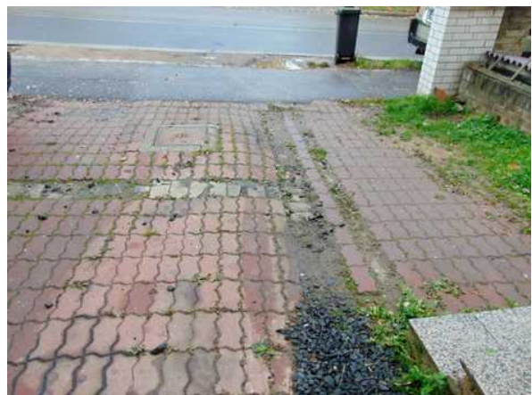
zpevněná plocha před domem
