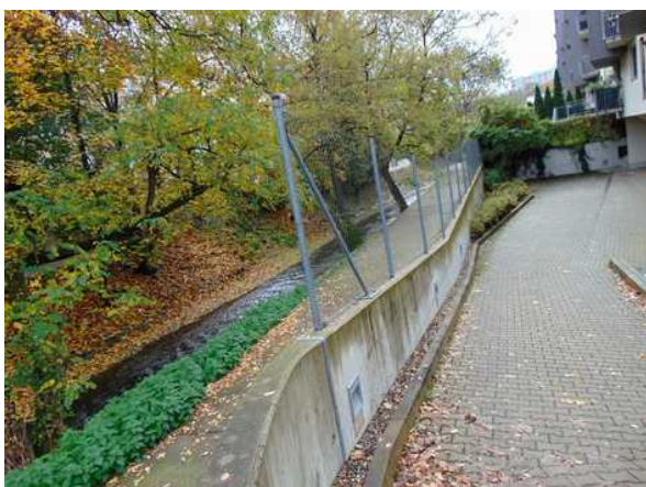
zpevněná část pozemka a koryto Botiče
