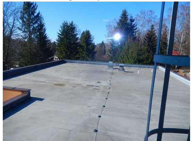
pohled na střechu stravovací části
