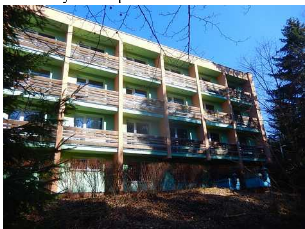
jižní pohled - lůžková část
