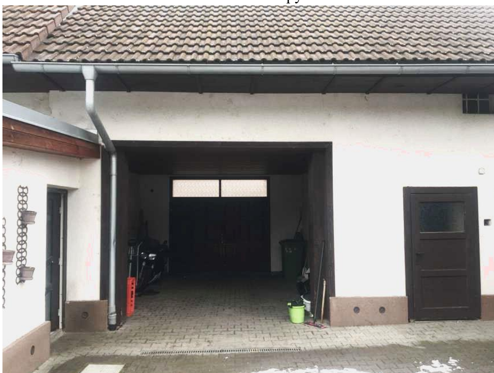
průjezd domem na dvůr
