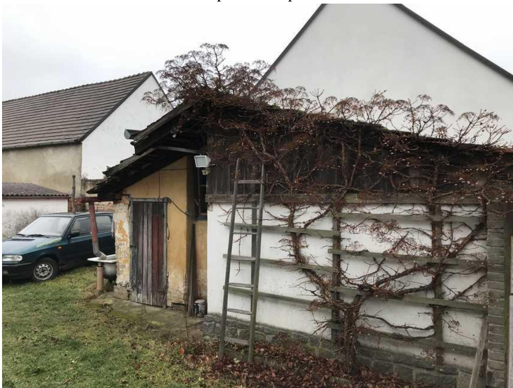
vedlejší stavba dřevníku na části st. p.č. 176
