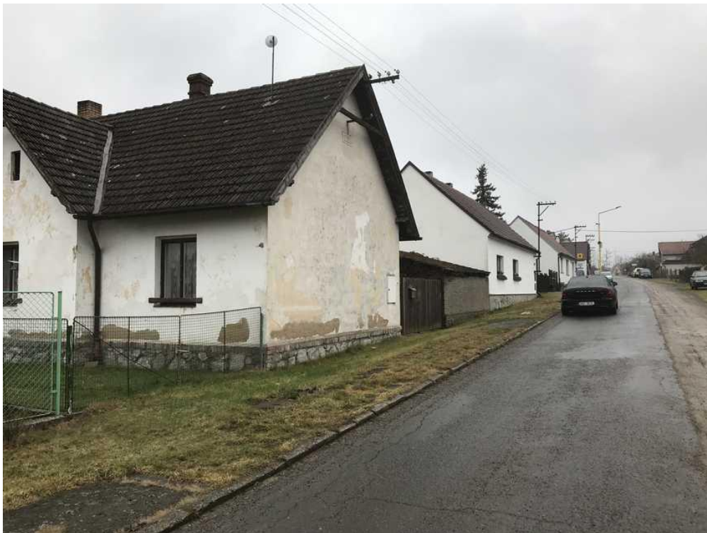
RD č.p. 136 s příjezdovou komunikací
