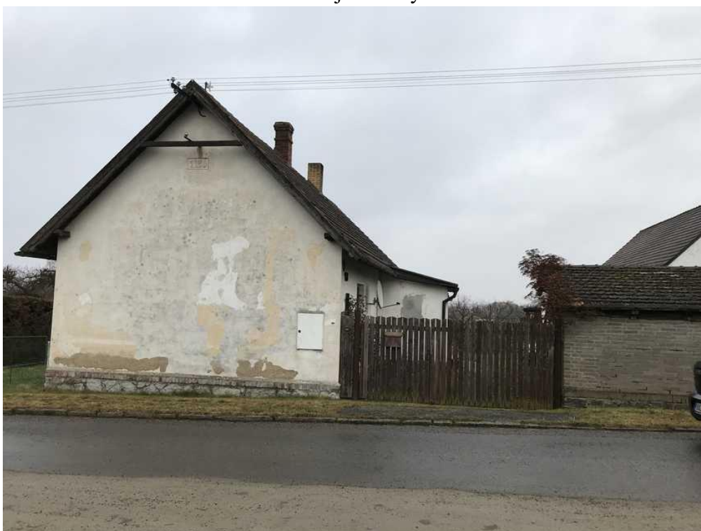
západní pohled na RD č.p. 136
