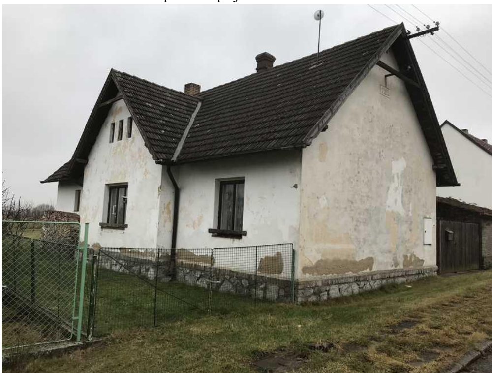
severní pohled RD č.p. 136
