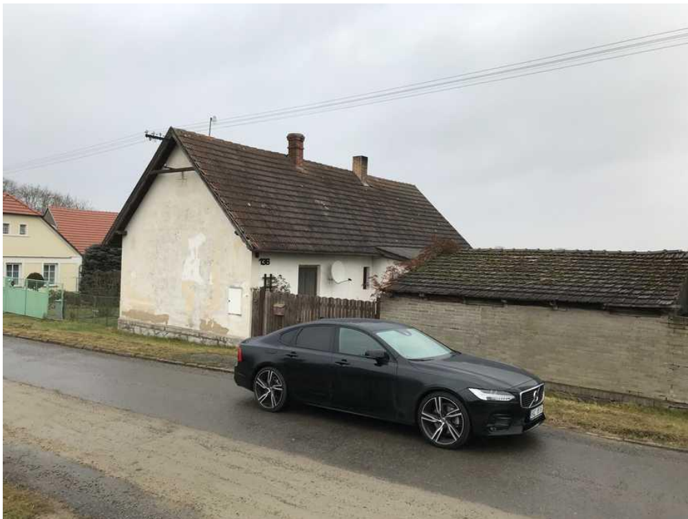
západní pohled na RD č.p. 136
