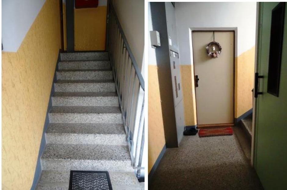
chodba, vstup do bytu
