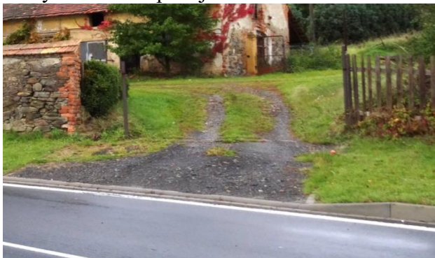
jihovýchodní vstup a vjezd
