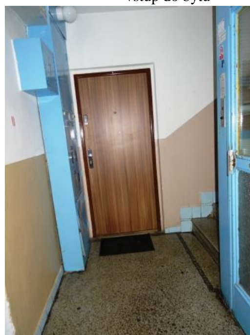
vstup do bytu
