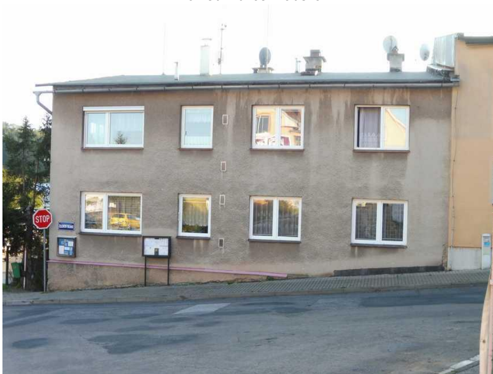
Pohled z ulice Na Koletově
