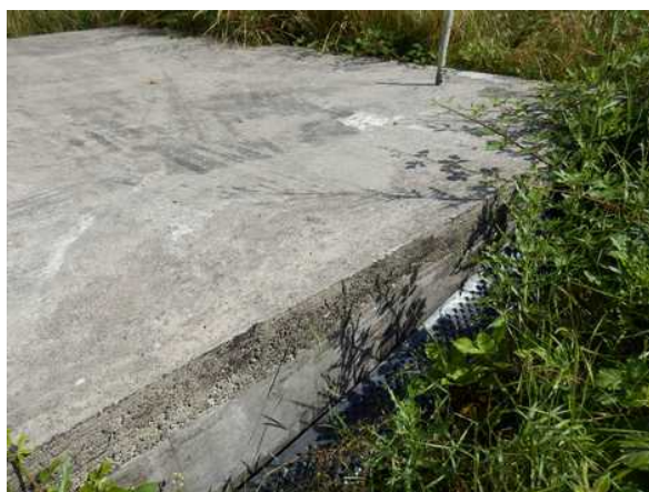
Oceňované pozemky - betonová deska na st.p.č. 1227 - detail na způsob provedení
