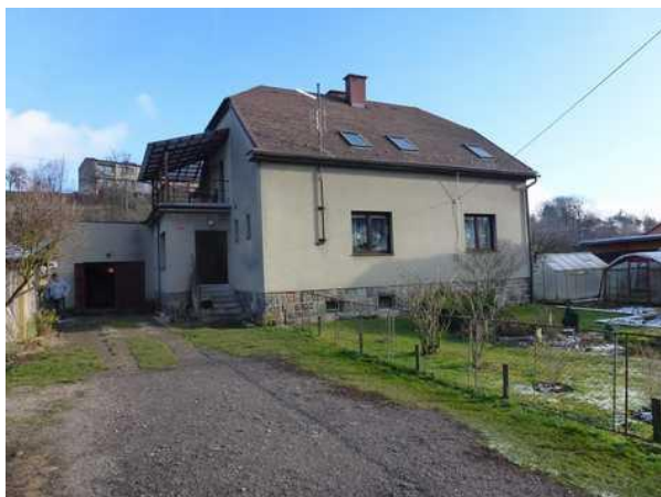
pohled z komunikace
