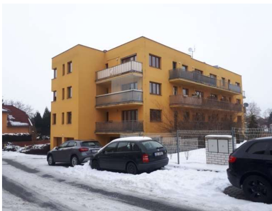
Pohled z ulice
