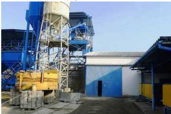
Vstup do výrobní haly z nádvoří, vlevo navazuje technologická linka, vpravo přístřešek
