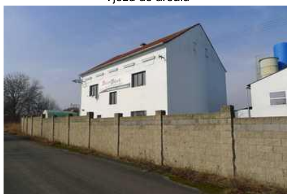
Budova č.p. 69 ze SV strany
