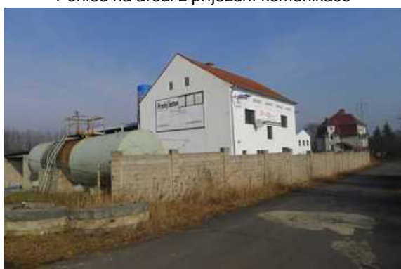
Budova č.p. 69 z JV strany
