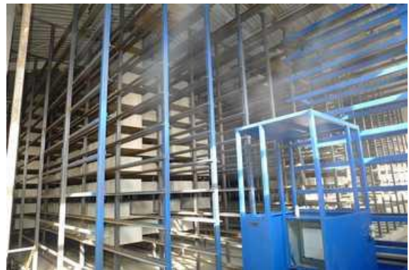
Interiér výrobní haly s technologií
