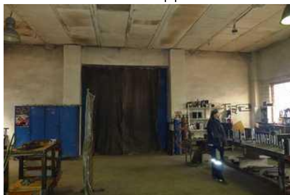
Dílenská hala - interiér
