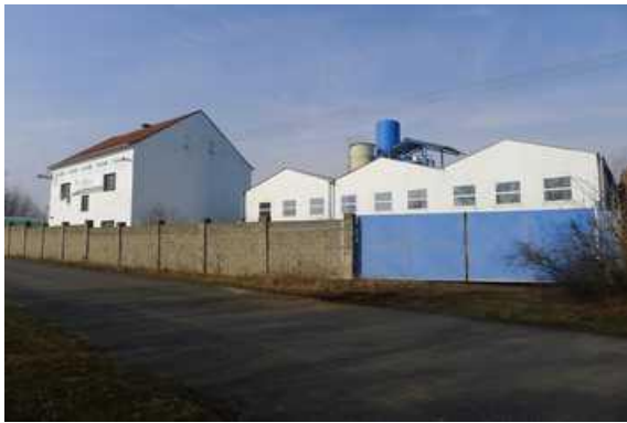
Výrobní hala trojlodní na st.p.č. 236 (podle GP) pohled z příjezdní komunikace
