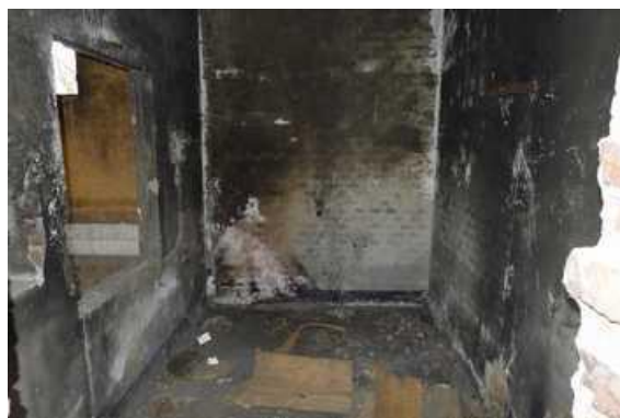
Místnost bývalé strojovny
