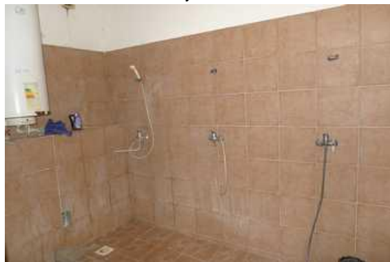
Interiér budovy - umývárna
