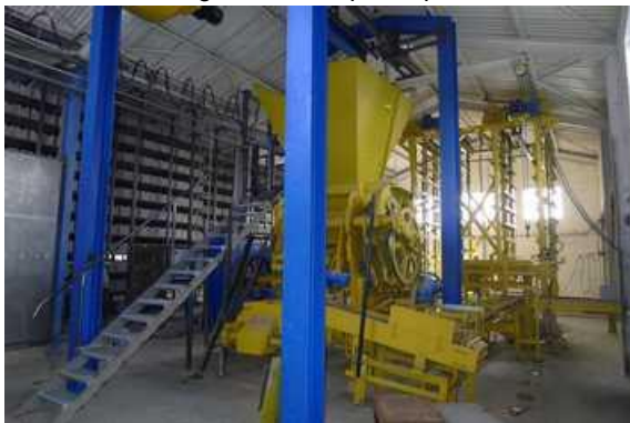
Interiér výrobní haly s technologií
