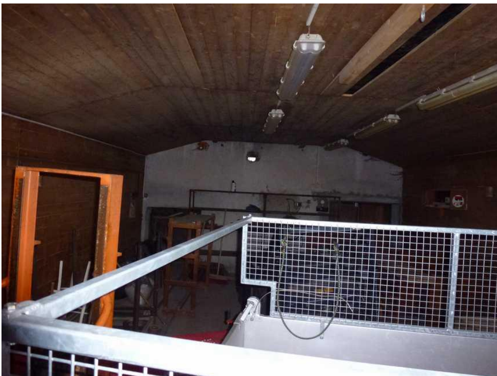
garáže pronajaté firmě Zahradnictví Mimoň interiér (foto ze dne 12.12.2018)
