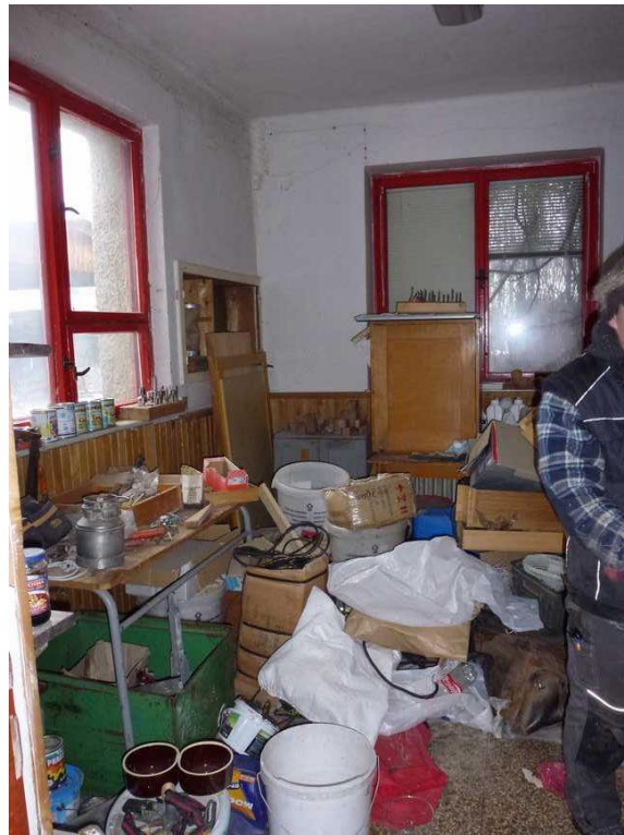
administrativní budova I.NP (foto z 12.12.2018)
