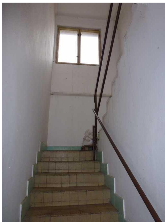
administrativní budova I.NP schodiště do II.NP (foto z 12.12.2018)
