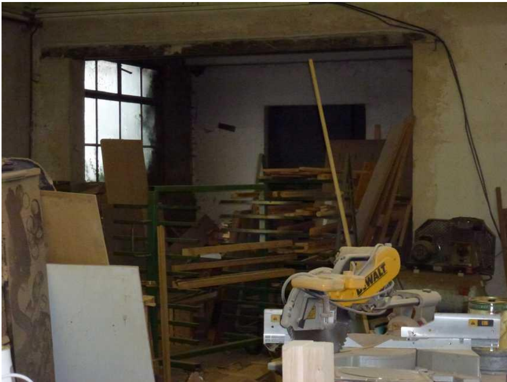
objekt truhlárny I na severní straně areálu (foto z 12.12.2018)
