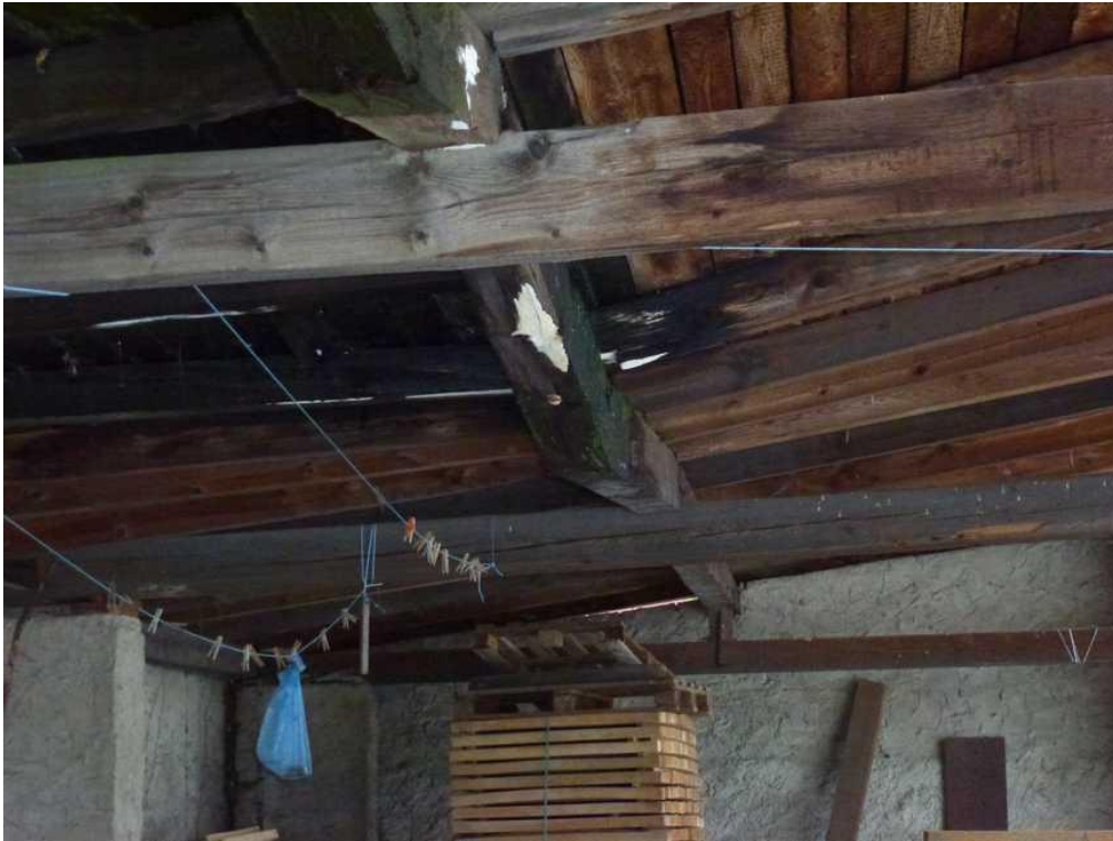
stav střešní konstrukce (foto z 12.12.2018)
