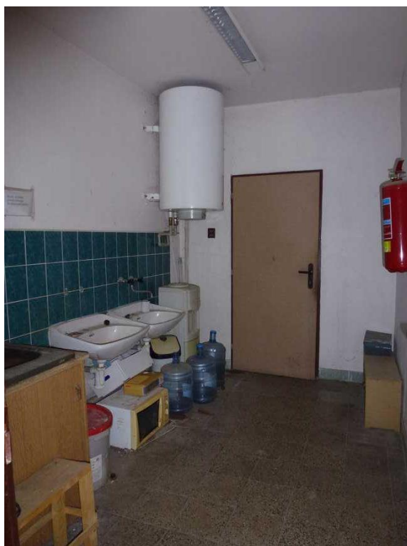
administrativní budova I.NP (foto z 12.12.2018)
