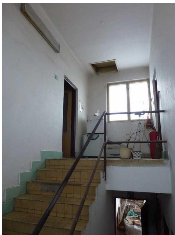
administrativní budova II.NP (foto z 12.12.2018)
