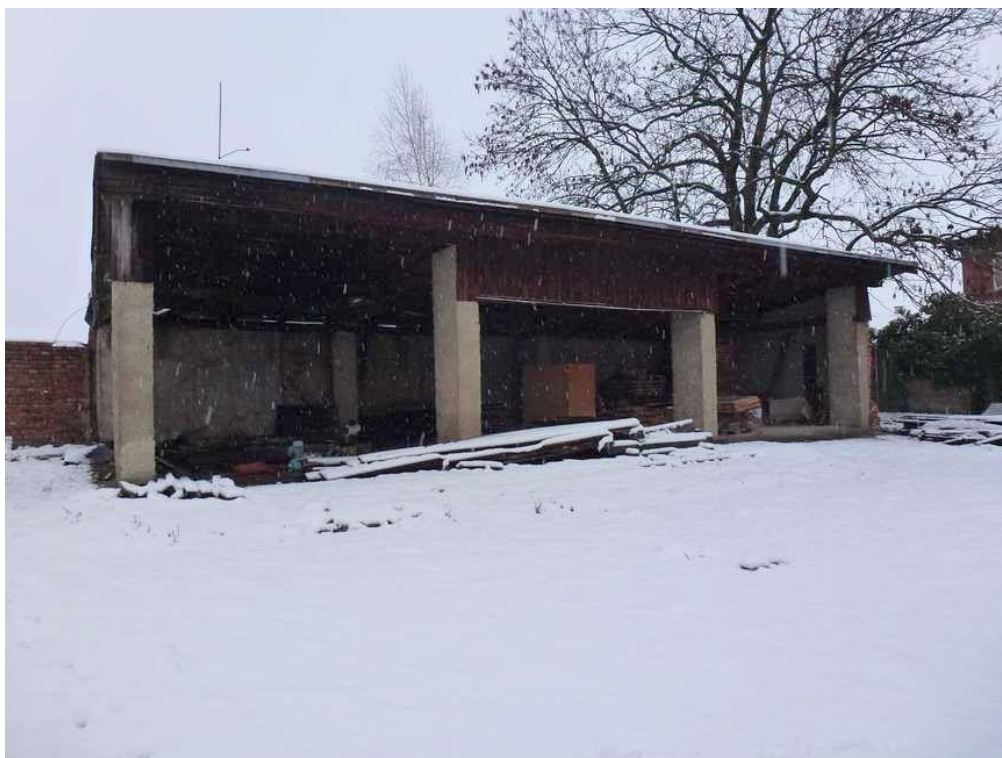
přístřešek na východní straně parc.č. 2601 (foto z 12.12.2018)
