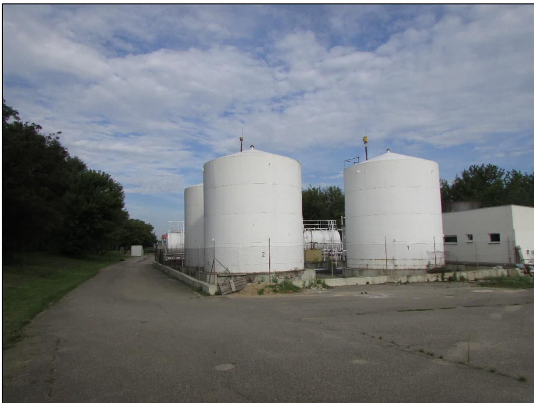
Obr. 7 – Skladovací nádrže, pohled východní
