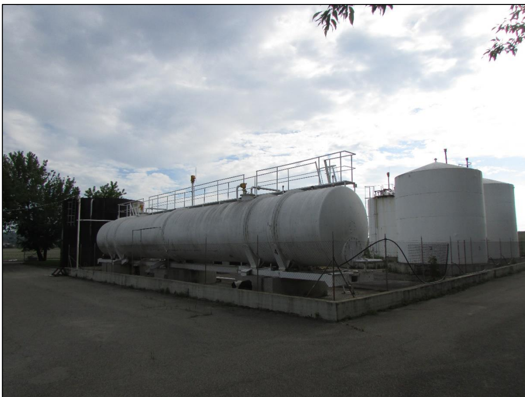
Obr. 8 – Skladovací nádrže, pohled západní
