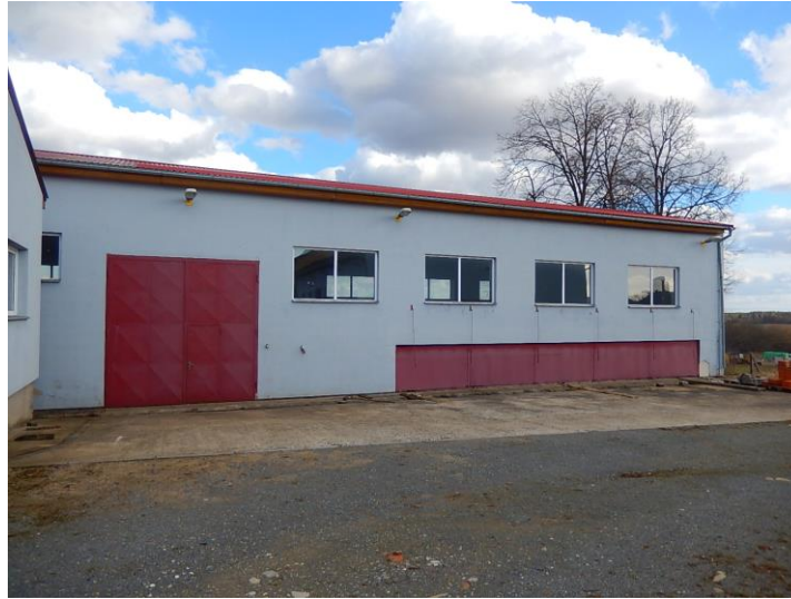
výrobní budova na st. parcele č. 224
