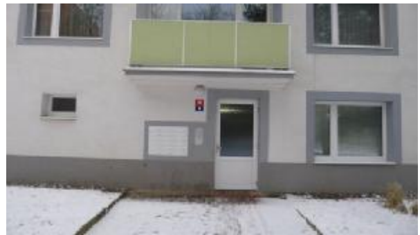
Vchod do domu č.p. 729
