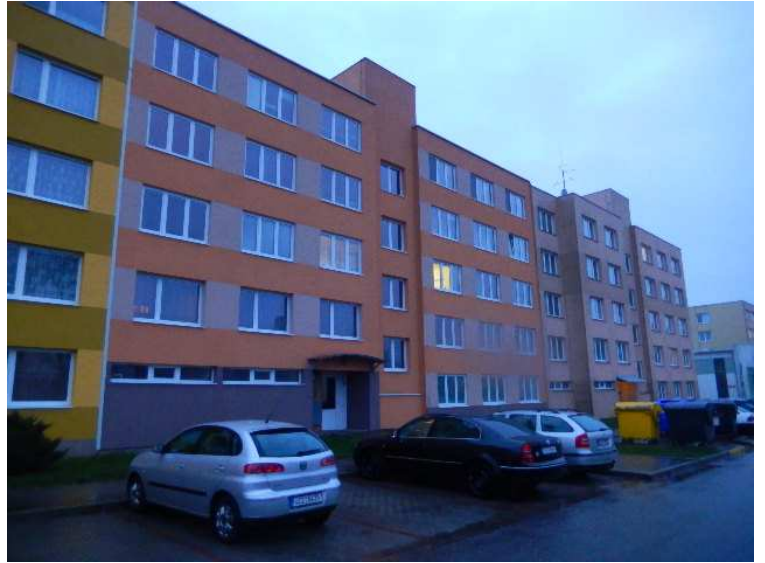
čelní pohled na BD č.p. 185
