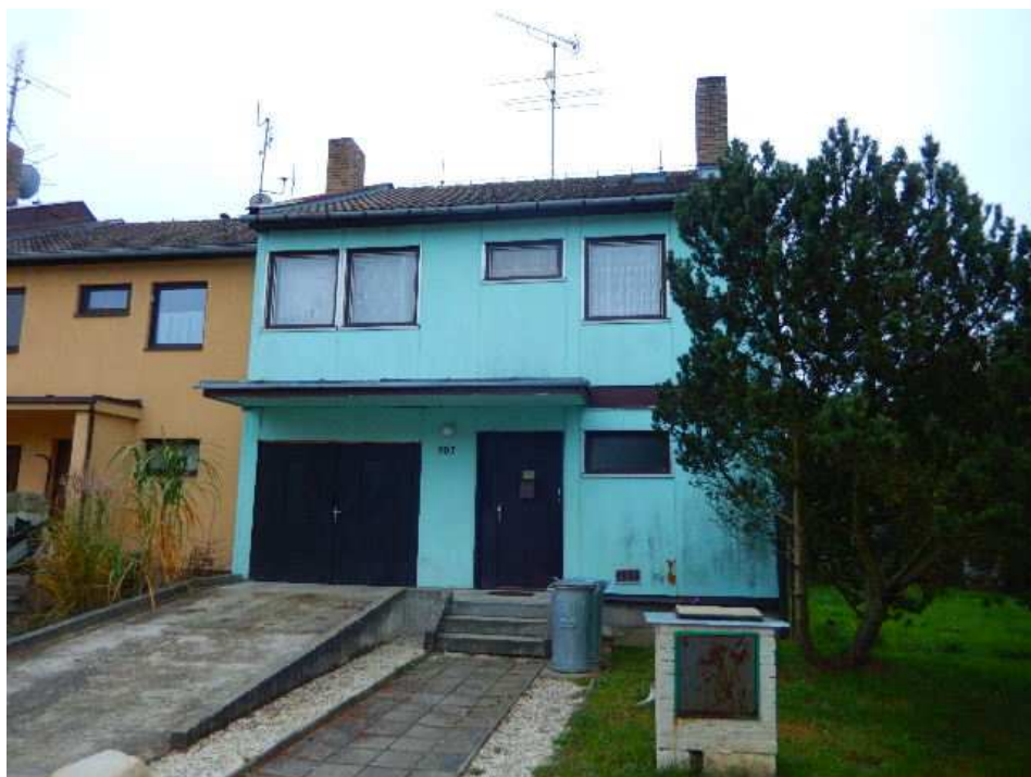
uliční pohled na RD č.p. 797
