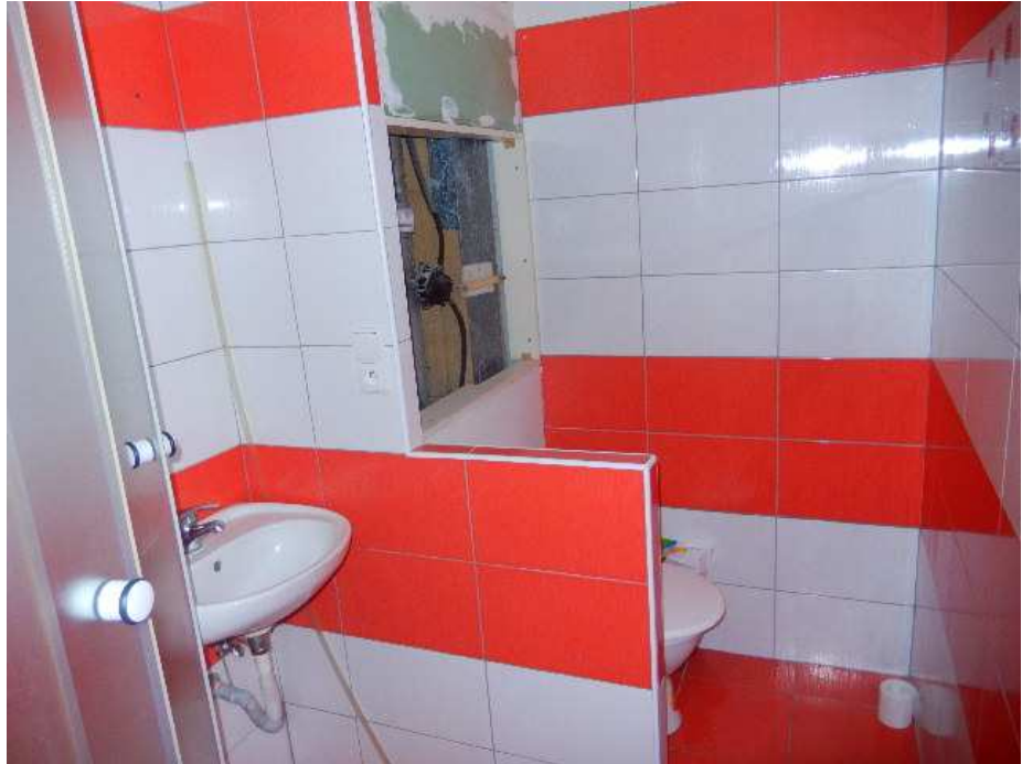
koupelna v bytě č. 2415/12
