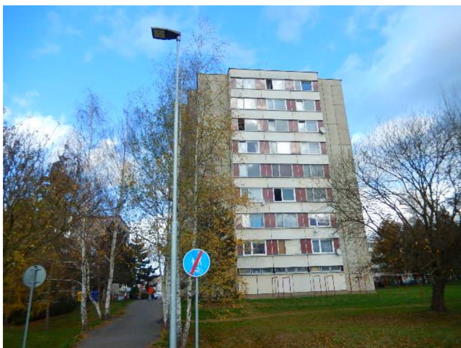
jižní pohled na BR č.p. 2287
