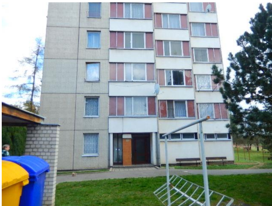
čelní pohled na BD č.p. 2287
