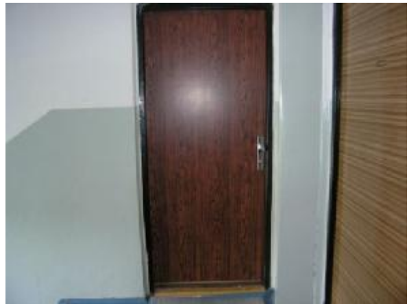
Vstup do bytu č. 5011/15
