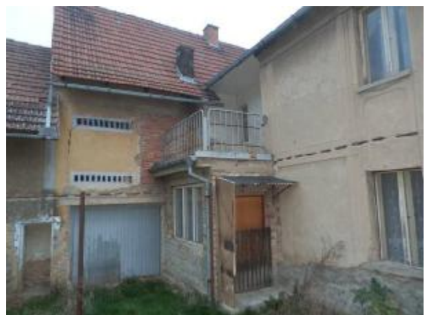
Vstup do rod. domu č.p. 81
